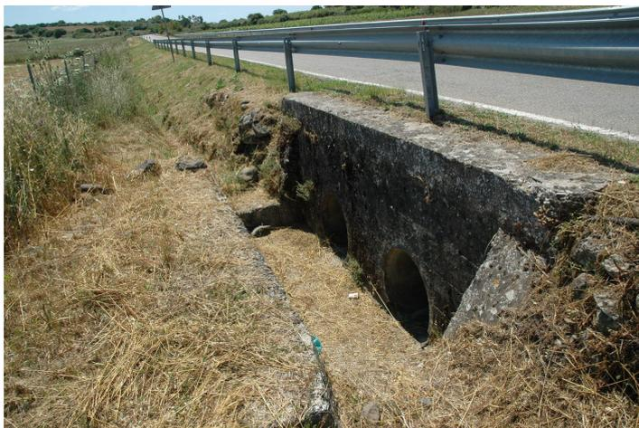
**Figure 33: Attraversamento strada Provinciale N. 10 con due tubolari in cls  $\varnothing 80$**
