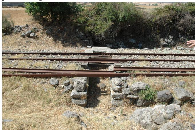
Figure 43: Rio "Terra Padenti", attraversamento ferroviario
